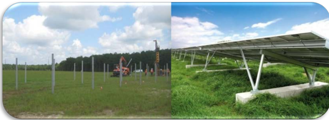
Figure 90 : Fondations des supports. Pieux vissés à gauche, longrines à droite
