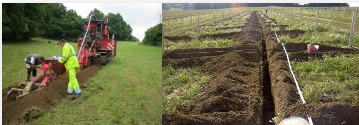
Figure 85 : Illustrations d’enfouissement de câbles électriques
